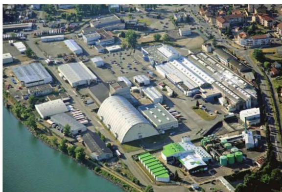
Grâce à une boucle d'eau fermée, la chaleur produite lors de la fabrication des lubrifiants du site est désormais récupérée et valorisée pour chauffer les bâtiments.
